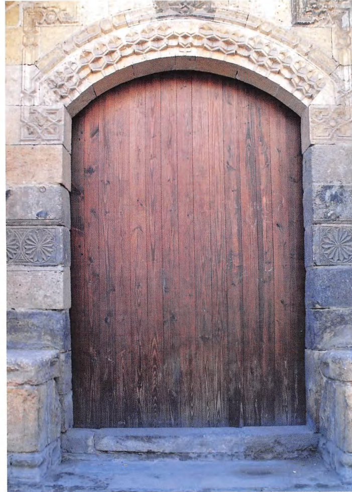
(لوحة 12) كتلة المدخل، العقود المتوترة المتوجهة لفتحة المدخل الرئيسي.
